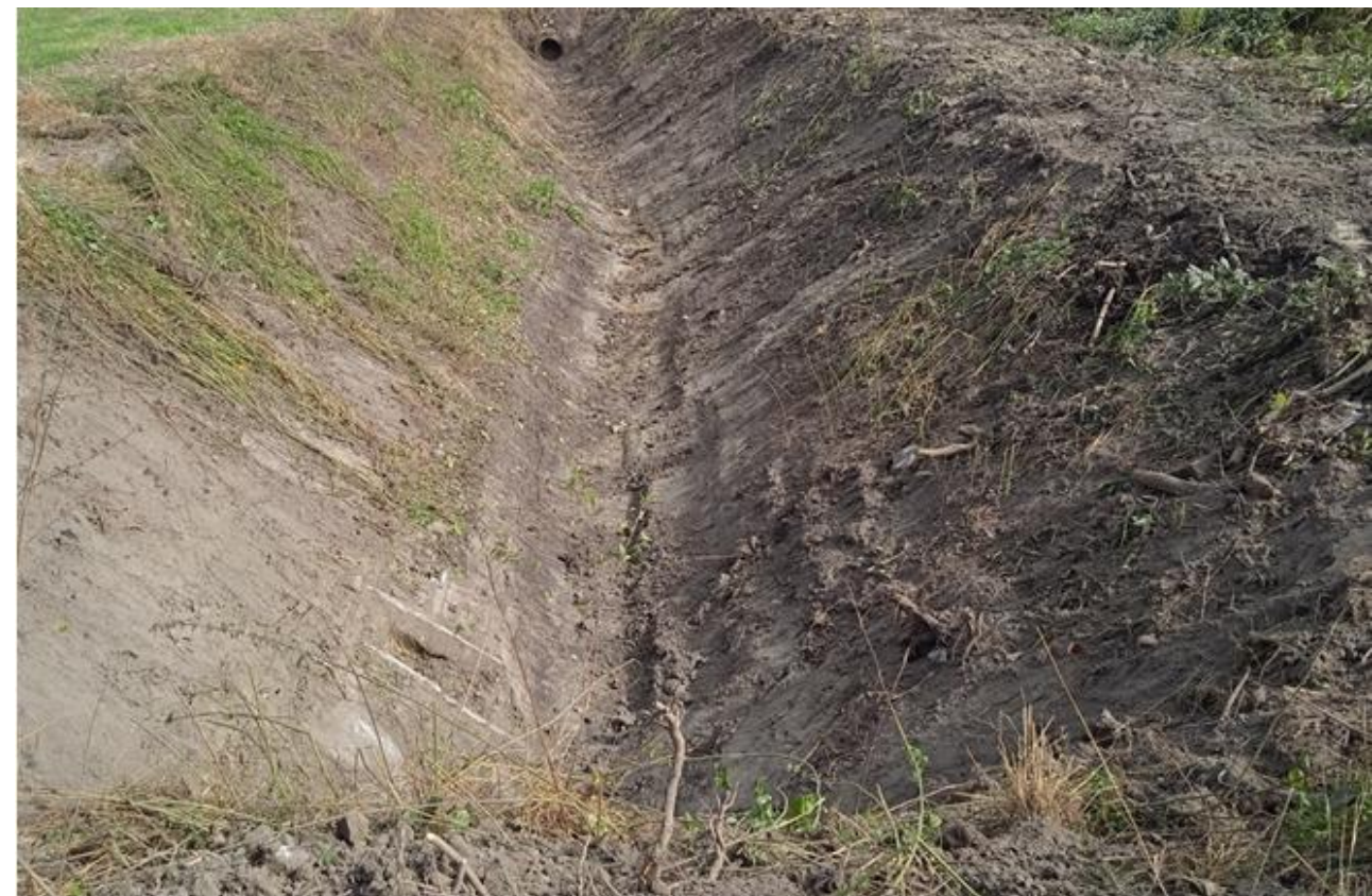
Rys. 3.14. Rów melioracyjny po konserwacji, Wiejca, 09.2022; źródło: Gminna Spółka Wodna „Kampinos”
