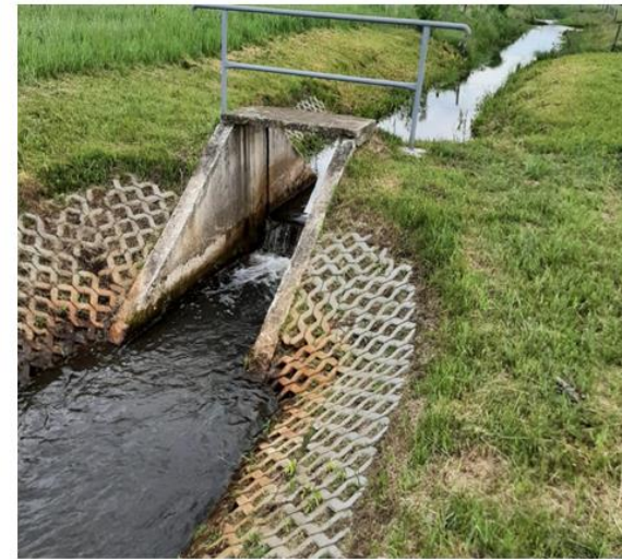
Rys. 1.2. Zastawka po wykoszeniu skarp w obrębie budowli w powiecie białobrzeskim; źródło: [warszawa.wody.gov.pl]
